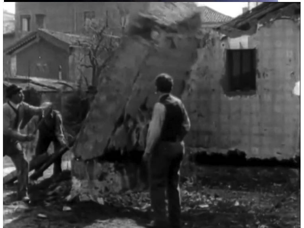
Démolition d'un mur, Vue Lumière, 1896
